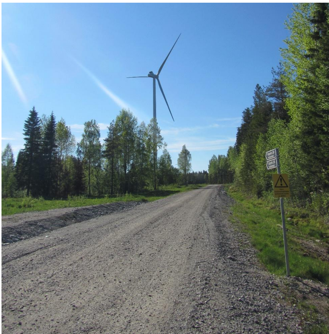
Kuva 2-7. Esimerkki tuulipuiston rakennus- ja huoltotiestä. © AFRY Finland Oy.
