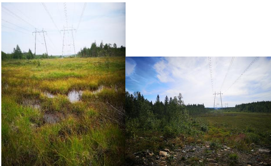
Kuva 9-4. Vasemmalla Kotasuon ruopparimpeä olemassa olevien voimajohtojen ja oikealla yleiskuvaa olemassa olevasta johtoaukeasta Rynnäsentiä alueelta kohti etelää (hankealueen suuntaan) kuvattuna. Suunniteltu voimajohto (SVE2) sijoittuu kuvassa näkyvistä voimajohdoista katsoen vasemmalle puolelle.
